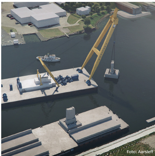
Visualisering af hvordan brofundamentet til Masnedundsbroen bliver sejlet på pramme og løftet ned i vandet.
